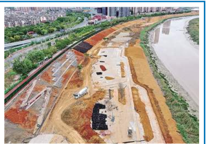
“八二一”人民廣場（左岸段）建設現場。
