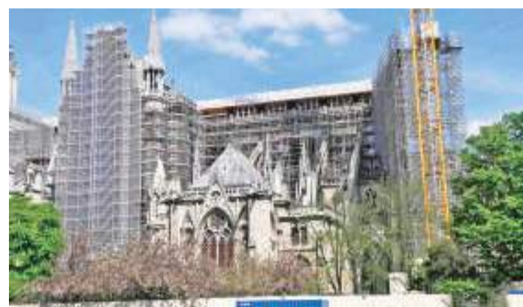
资料图:2022年4月15日是巴黎圣母院大火三周年。巴黎圣母院临时的金属脚手架已经搭建完毕,以保证巴黎圣母院结构稳定。中新社记者 李洋 摄
