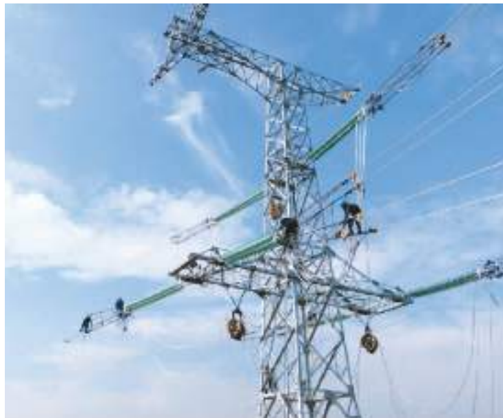
春节前夕，南方电网广东电网公司全力加快500千伏粤港澳大湾区外环西段、东段等重点工程建设，提升大湾区电力供应保障能力。图为在工程建设现场，该公司建设者正在推进导线展放的施工任务。 陈海东摄（人民视觉）
