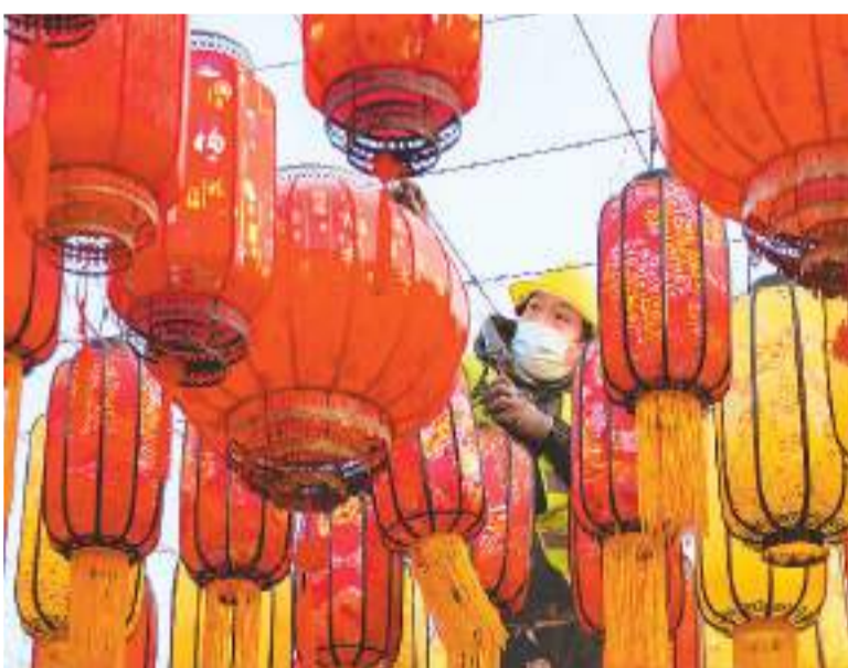
1月3日，在山西省运城中心城区南风广场，工人在安装节日花灯。姜 桦摄（人民图片）
