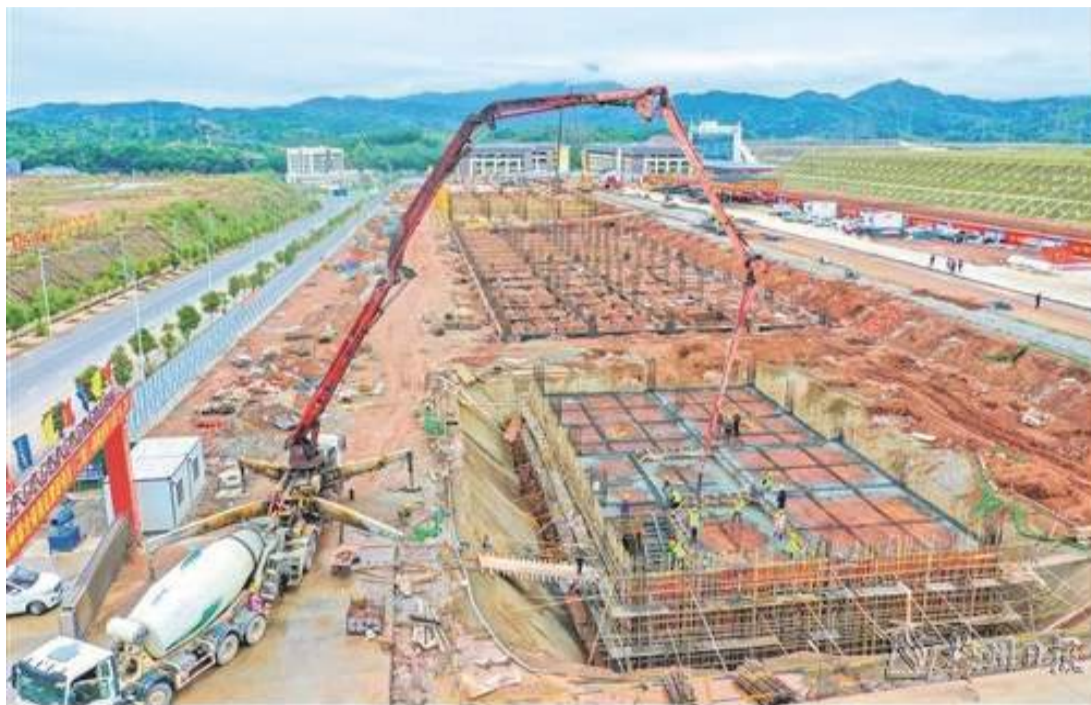
梅州綜保區保稅倉庫項目建設現場一派火熱施工景象。(吳騰江 攝)
