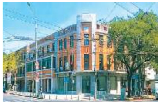
近期完工的“西安门大街街区改造提升项目”，折掉冗余的装饰并对墙面进行精细打磨，露出红楼本来的面目；红砖砖面上具有历史时代感的标语字样等历史信息也同样保留下来。现在的红楼影院已是一座公共藏书楼，成为人们阅读西安门历史的文化场所。
