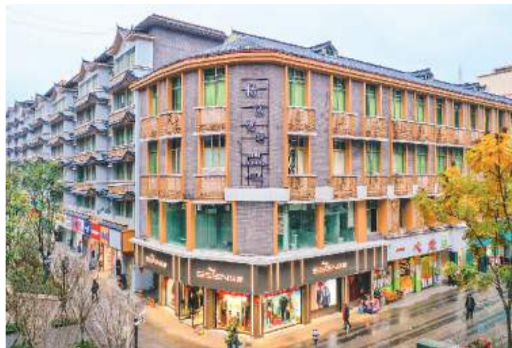
四川省宜宾市兴文县古宋镇中山街改造完成的老旧小区焕然一新。
