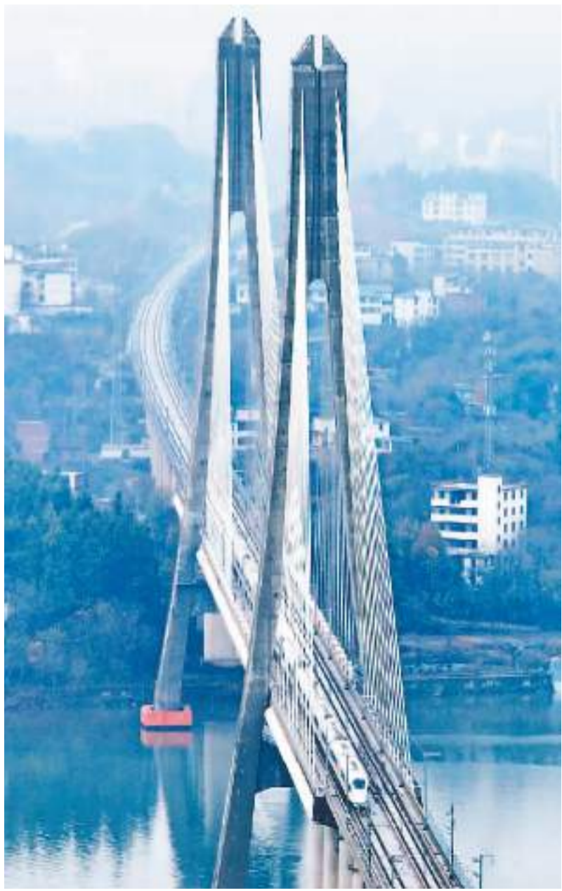
春运期间，南昌铁路局赣州车务段科学精准安排运力，增强路网整体功能，提升客运能力。按照“充足安排、按需启动，响应快速、应急有备”原则，助力旅客安全有序出行。图为1月13日，高铁列车在江西省赣州市赣江特大桥上疾驰。朱海鹏摄(人民视觉)
