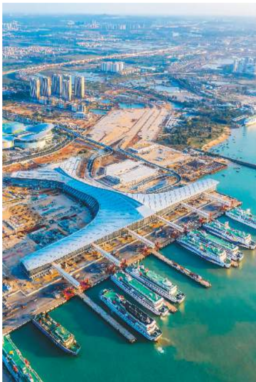
海南省海口新海港滚装码头客运综合枢纽站工程项目幕墙施工已经完成95%, 目前该项目主体结构已竣工。建成后, 将实现游客过海“零换乘”, 大大提高海口新海港的服务水平, 助力海南自由贸易港建设。图为2月7日海口新海港滚装码头客运综合枢纽站工程项目。石中华摄(人民日报)
