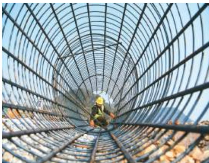
2月1日，贵州省2023年一季度重大项目集中开工，图为工人在贵安新区美的云一期土建总承包工程项目现场施工。新华社记者 杨文斌摄
