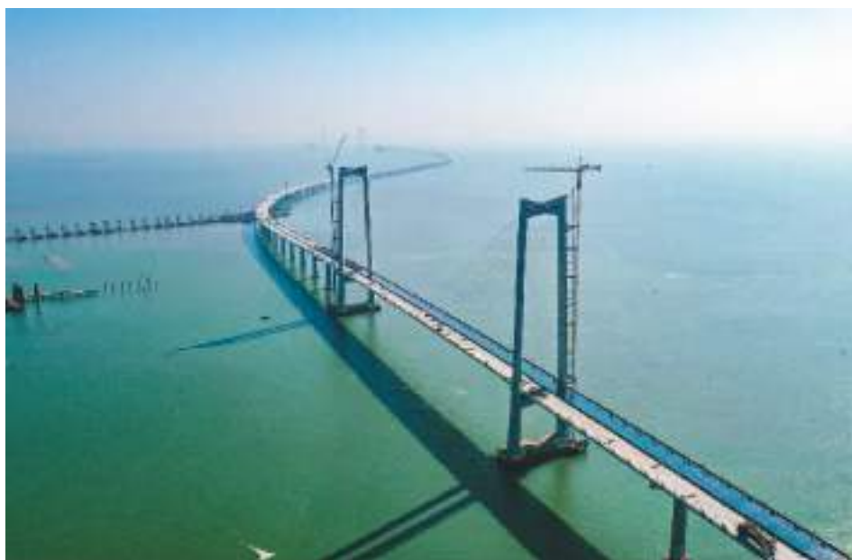
1月19日，深中通道进行钢桥面铺装作业。 陈文欣摄
