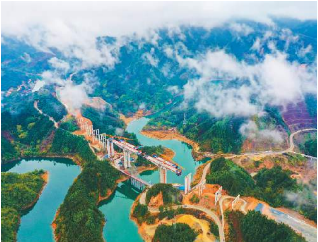
融从高速公路是广西重大项目之一，一期工程全长五十六公里，起于广西融水苗族自治县浮石镇，沿线经融水苗族自治县、怀宝镇和安大乡，与融从高速公路二期工程衔接，从融水苗族自治县进入贵州从江县。项目建成后，将进一步密切黔桂两省间的公路联系。图为近日，中国一冶建设者在四荣乡路段的融从高速公路施工现场。
