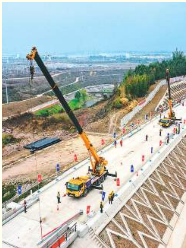
施工人员在位于重庆市永川区的渝昆高铁施工现场架设接触网杆。 新华社记者 唐奕摄
