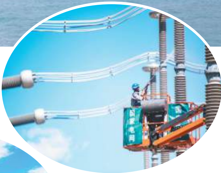
▲ 北京市延庆区八达岭镇里炮村，检修工人在张北柔性直流电网延庆换流站清洗绝缘立柱。
