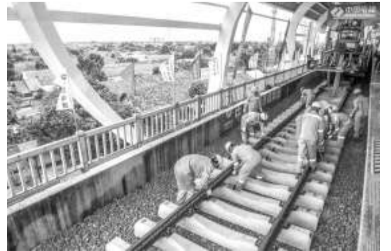
雅万高铁完成轨道安装工作
