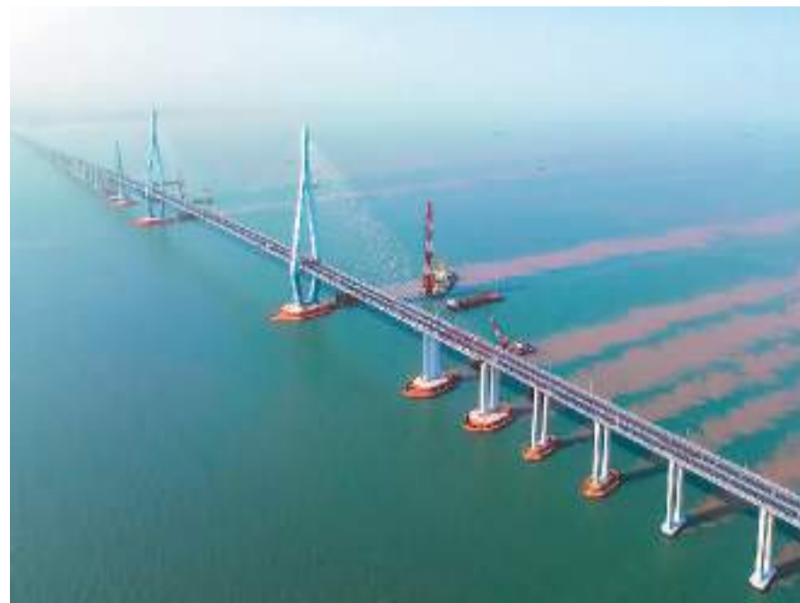
浙江宁波至象山市场(郊)铁路工程象山跨海大桥项目鄞州段日前开始海上作业,标志着国内首座市场(郊)铁路跨海大桥全线开工,施工按下“加速键”。 胡学军摄(人民视觉)
