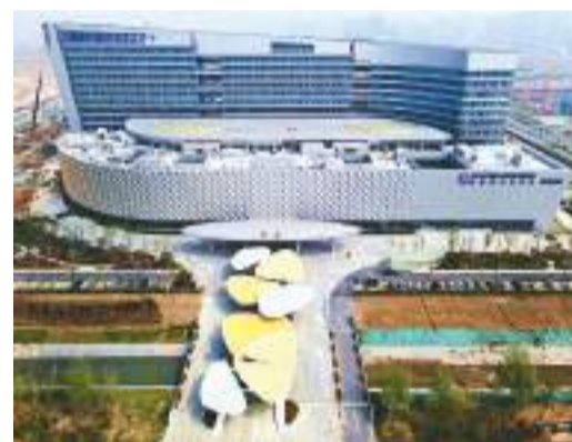
4月1日,航拍的安徽省合肥市深圳路国家儿童区域医疗中心。该基建项目即将全面竣工,目前已进入内装施工阶段。 方好摄(人民视觉)
