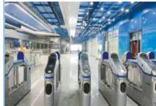
正在進行機電施工的深井站。記者 黃裕勇攝
