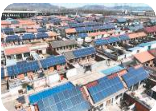
河北省玉田县孤树镇庄户村的屋顶分布式光伏面板（无人机照片）。新华社记者 牟宇摄
