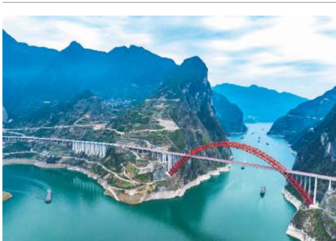
据交通运输部长江三峡通航管理局消息,今年第一季度,三峡枢纽航运通过量3989.36万吨,同比增长22.08%,创继挂以来一季度航运通过量最高纪录。图为船舶行驶在长江三峡湖北省宜昌市秭归县水域。 杨东摄(人民图片)
