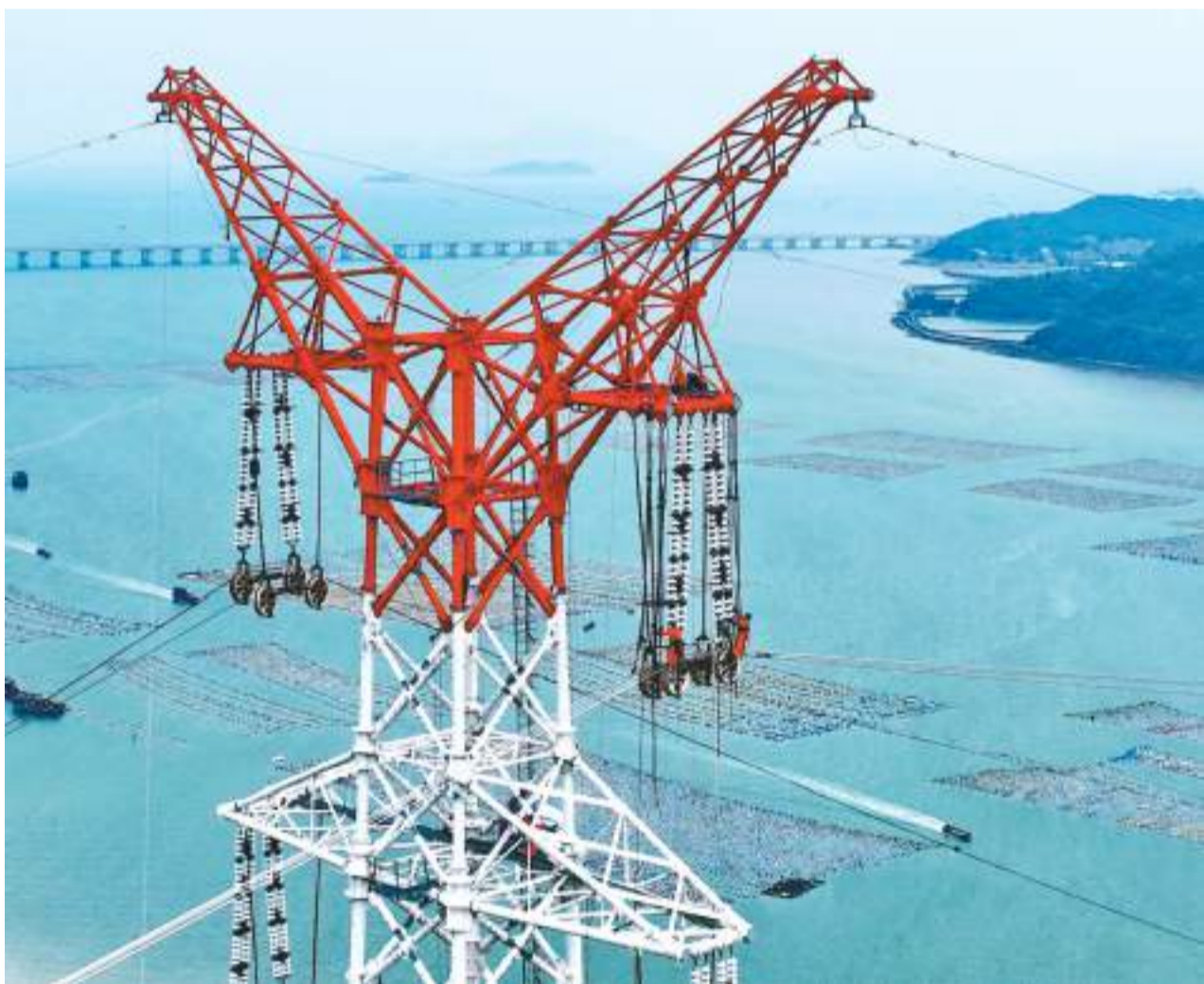
近日,福建漳州核电500千伏送出工程施工现场,施工人员在横跨1500米的漳江跨越线路百米上空进行四回线路同时跨江作业,全力推进工程进度。图为施工人员在电力钢管塔上作业。 新华社记者 林善传摄
