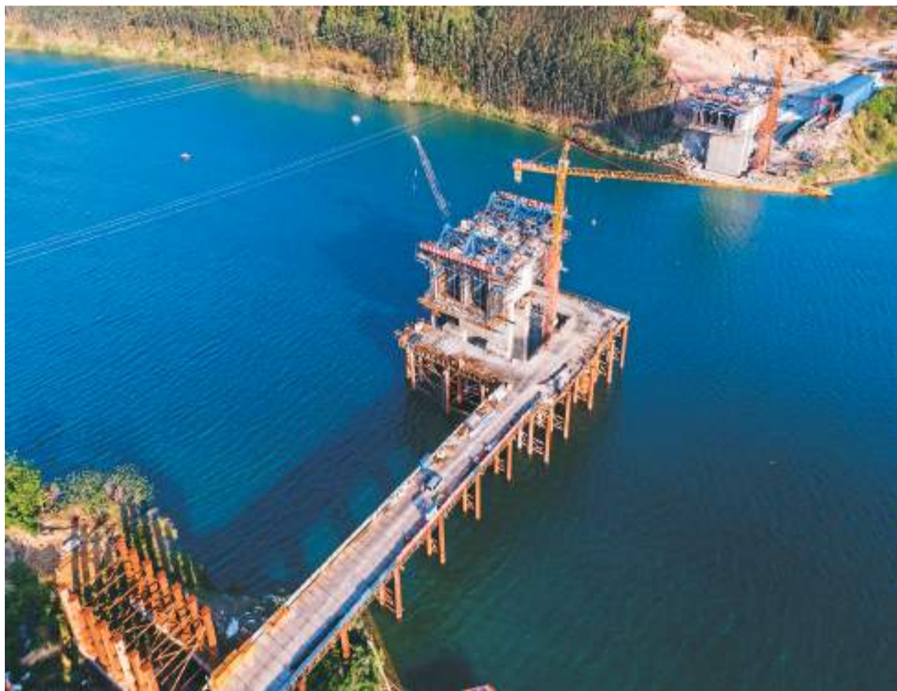
广西壮族自治区柳州市融水苗族自治县融水三桥是当地重点民生工程之一，主桥长395米，引桥长120米，桥宽24米。大桥建成通车后将完善当地路网结构，助力乡村振兴。图为建设中的融水三桥。 龙涛摄(人民视觉)
