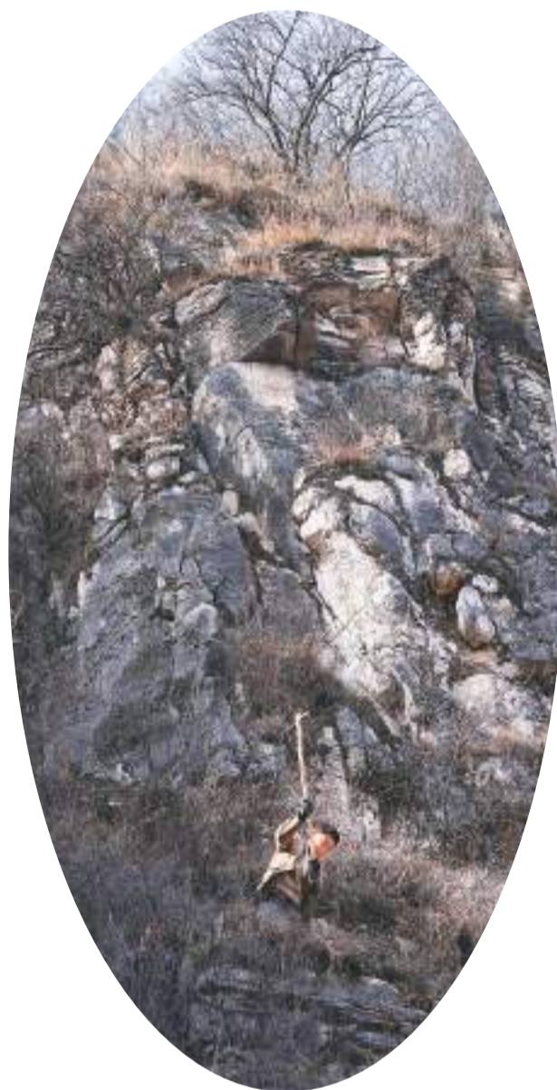
▲ 青龙峡村村民申森在清理路基上的杂物。 ▶ 村民挑着石块运往修路现场。 ▼ 村民在修路间隙歇脚休息，补充体力。
