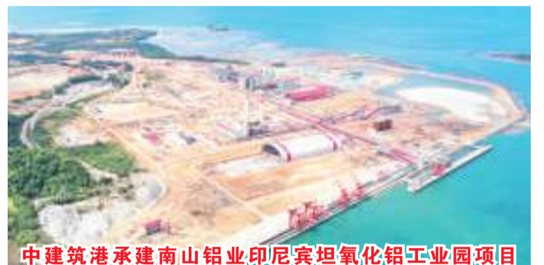
中建筑港承建南山铝业印尼宾坦氧化铝工业园项目
