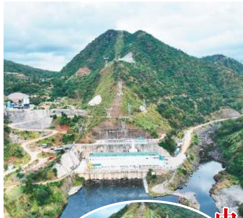
日前在赞比亚南方省航拍的下凯富峡水电站发电厂房。（新华社发）
