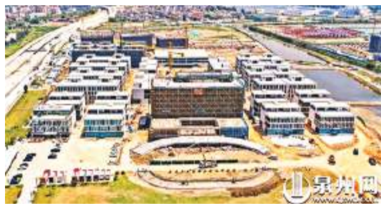
中信重工智慧产业园建设现场
