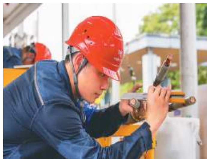
2023年全国电力行业电力电缆安装运维职业技能竞赛近日在广州举行,来自央企的34支队伍80名选手参赛。竞赛代表了中国电力电缆安装运维的最高技术水准和能力,体现了新时代产业工人的青春奋斗精神。图为南方电网公司选手在竞赛现场就电缆安装运维工序进行比拼。
