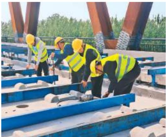
近日，由中铁上海工程局承建的郑济铁路（山东段）项目无砟轨道施工全部完成，为项目后续铺轨工作和通车运营奠定基础。郑济铁路是国家“八纵八横”高铁网的重要连接线，对优化国家铁路网布局、推动山东省中西部地区与中原地区互联互通意义重大。通车后，济南至郑州通行时间将缩短至2小时。图为工人在检查无砟轨道。 武文成摄（人民视觉）
