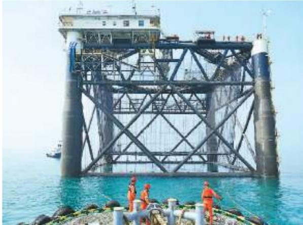
搭载自动监测、投喂、洗网等设备的大型深远海智能网箱平台“经海005号”在山东烟台长岛海域安装成功，助推当地渔业转型升级。唐 克摄(人民图片)
