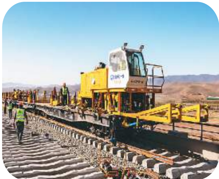
5月26日，在甘肃省武威市天祝藏族自治县新建兰州至张掖三四线铁路(简称兰张三四线铁路)下河东特大桥施工现场，随着一组500米长钢轨铺设在道床上，兰张三四线铁路兰武段铺轨工程正式开始。赵世鹏摄(人民视觉)
