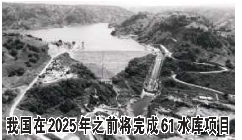
我国在2025年之前将完成61水库项目 图示:南苏省杰内彭托县(Jeneponto)的Karalloe水库在5月27日的情景。如悉,公共工程与民居部定下指标,61座水库必须在2025年之前建成,目前已有36座水库已建成并投运了。
