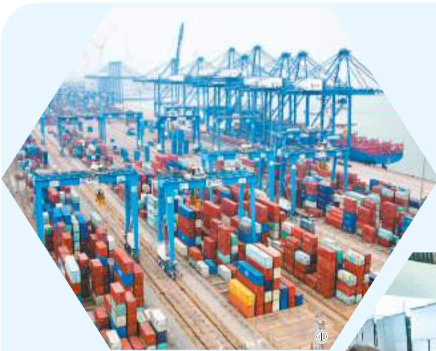
图①：图为天津港北疆港区C段智能化集装箱码头。
