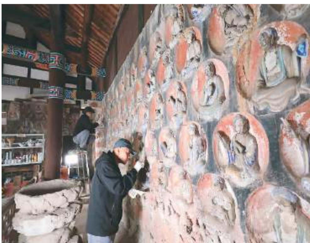
▲2023年3月31日，大足石刻小佛湾修复现场，修复人员正在对石窟造像进行清理。小佛湾石窟保护修复工程于2019年6月启动，目前已完成整个工程量的六成。 黄舒摄(人民图片)
