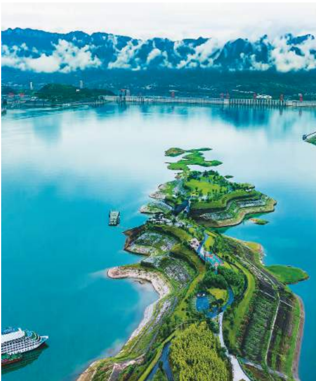
6月5日18时,长江水文网实时水情显示,三峡水库水位降至151.80米。为迎战即将到来的长江汛期,三峡枢纽正按计划有序推进水库汛前消落,最大限度发挥防洪、发电、补水、航运等方面综合效益。图为三峡大坝上游湖北省宜昌市秭归县木鱼岛天问公园,库岸水位下降后消落带清晰可见。郑家裕摄(人民视觉)
