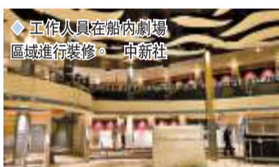
工作人員在船內劇場區域進行裝修。中新社
