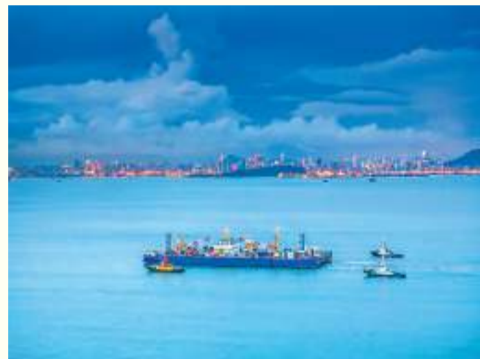
图为最后一个管节和最终接头正在浮运。苏振飞摄
