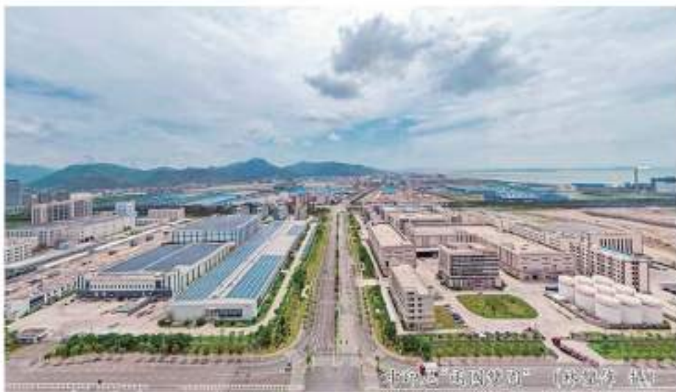
中印尼“兩國雙園”建設現場。
