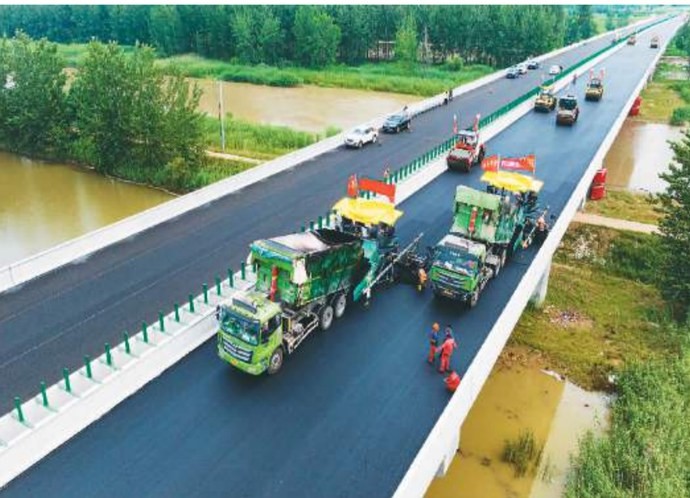
七月六日，位于江苏省宿迁市沭阳县内的宿连高速公路工程建设现场，施工人员进行摊铺沥青作业，全力推进项目进度。(周永摄(人民视觉))
