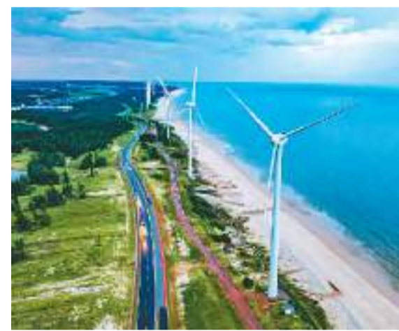
6月24日，海南省文昌市沿海环岛旅游公路旁，风电机组林立。 蒙钟德摄（人民视觉）
