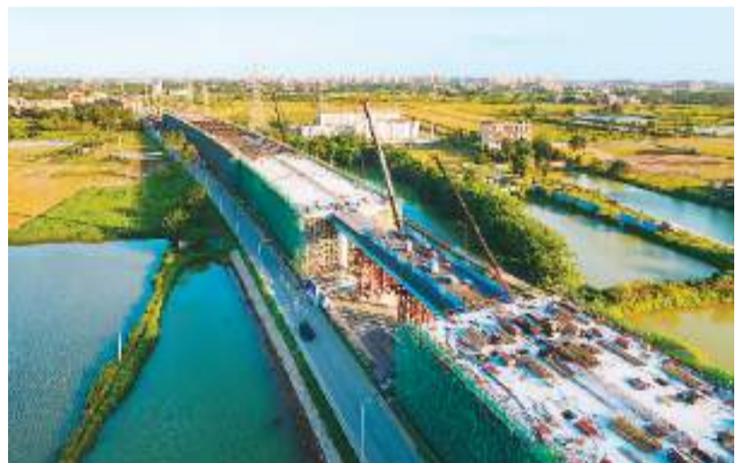
6月30日，由中铁上海工程局承建的海南省海口市江东新区快速通道项目主线桥1902根桩基施工全部完成，项目全线将进入上部结构施工阶段，为实现9月底功能性通车奠定了基础。该项目建成通车后将进一步优化海口道路交通体系，有效缩短美兰机场与琼北地区的行车时间。郭伟娜摄（人民视觉）
