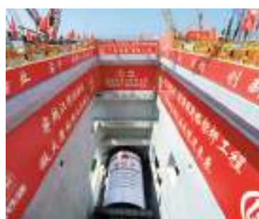
6月30日，膠州灣第二隧道工程參建單位工人代表揮舞旗幟慶祝盾構始發。
