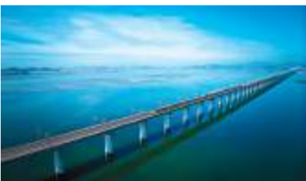
6月28日，在福建湄洲灣跨海大橋，試驗列車以單列時速453公里運行。
