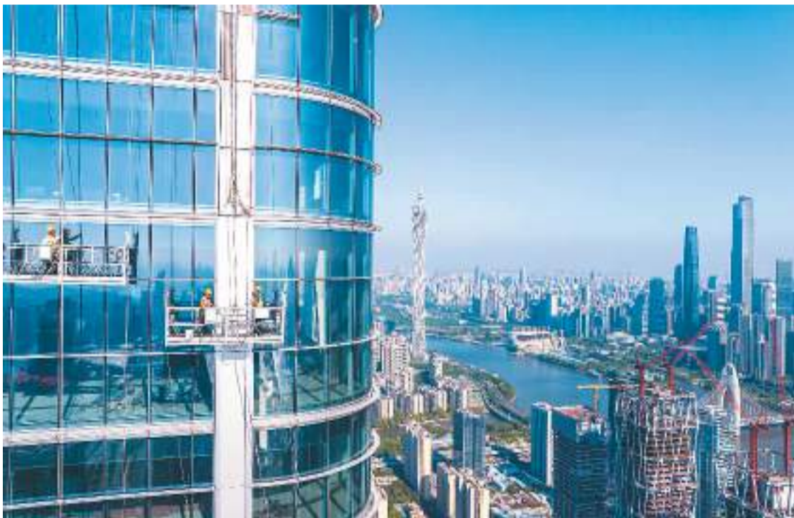
近日，在位于广东省广州市海珠区的琶洲人工智能与数字经济试验区核心片区，建设者在高空进行幕墙工程施工。
