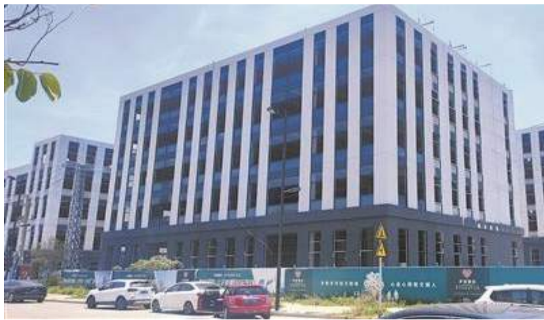
晉江新智造產業園項目一期主體結構已全綫封頂
