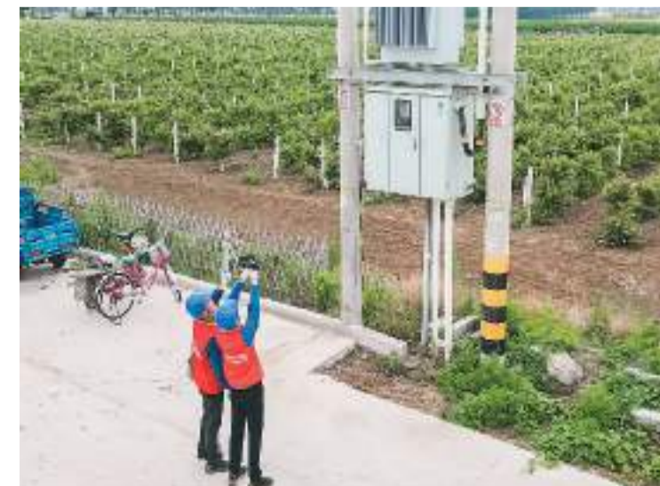
近年来，国网山东莱州市供电公司创新服务方法，开辟“绿色通道”，缩短各项业务流程，为新建居民小区提供精细化、专业化的供电施工服务。图为日前工人在新建小区进行电力施工。赵 冬 林硕斐摄影报道
