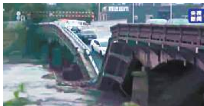
受永定河分洪影響,北京盧溝橋西側的小清河橋局部坍塌。 視頻截圖
