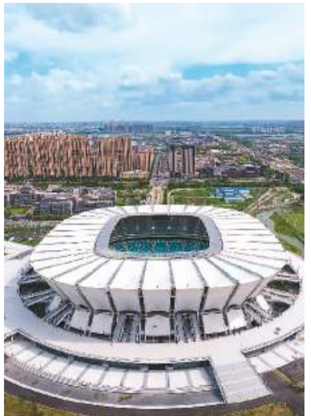
近日，江苏昆山奥体中心进入竣工验收阶段。这是江苏省内首座满足国际足联要求的世界一流专业足球场，建成后将成为昆山“新名片”。王须中摄（人民视觉）
