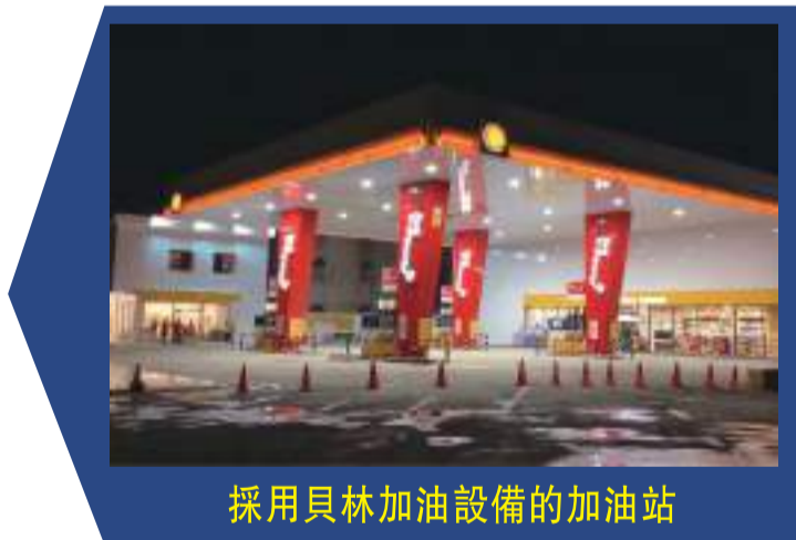
採用貝林加油設備的加油站
