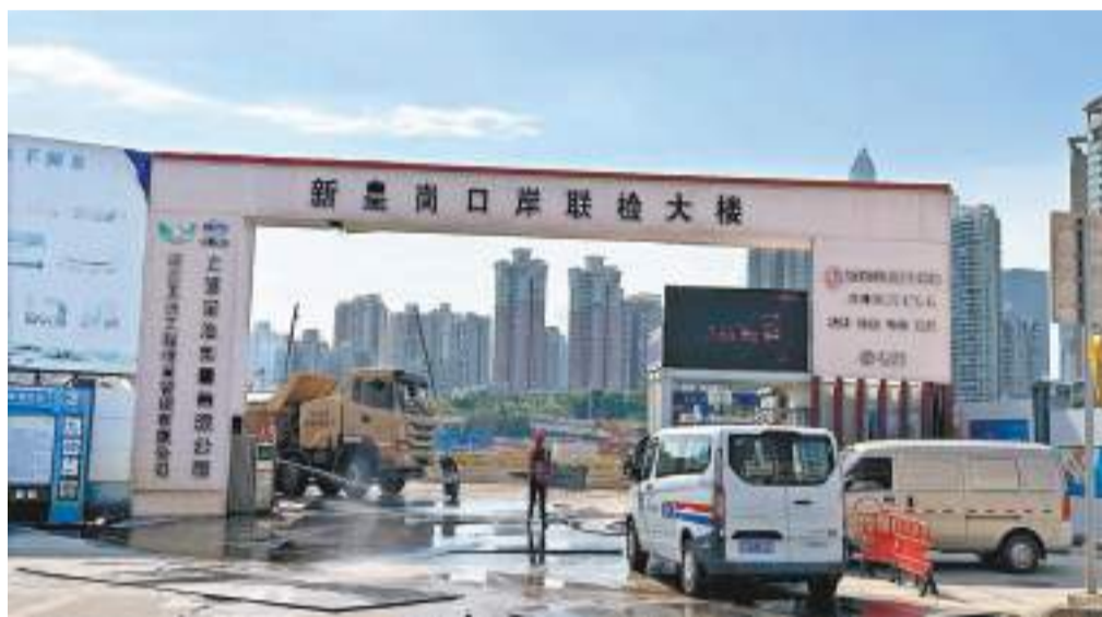
正在建設中的新皇崗口岸聯檢大樓。記者 朱輝豪攝
