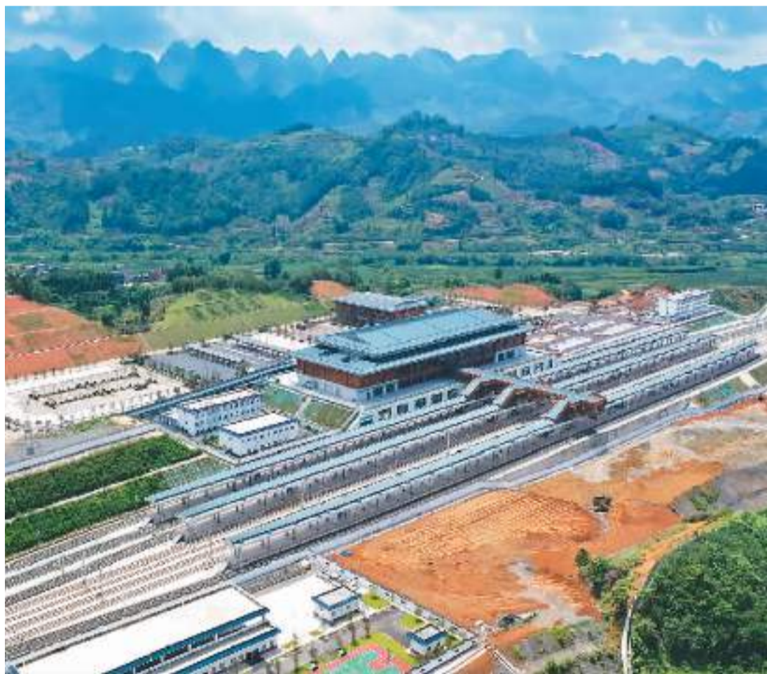
近日,贵南高铁荔波站站房整体建设完成。贵南高铁是我国“八纵八横”高速铁路网中内蒙古包头到海南海口通道的重要组成部分,也是黔桂地区首条设计时速350公里的高速铁路。贵南高铁开通后,从贵阳至南宁铁路运行时间将从现在的5个多小时缩短至2个小时左右。图为建设完成的荔波站站房及站台。
