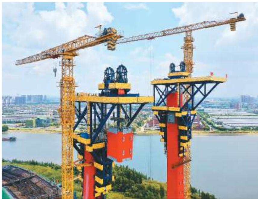
位于广东省佛山市顺德区的顺德大桥是超大跨径钢混组合索塔斜拉桥，由中交路桥承建，主桥全长992.5米，主跨266米，索塔采用变截面H型塔柱，塔高分别为204米、151米。目前，承建单位正采用自主研发的智能钢塔提升机进行顺德大桥主塔和横梁无支架整体安装作业。大桥建成后有效打通顺德融入粤港澳大湾区“一小时交通圈”的内部区域道路瓶颈。
