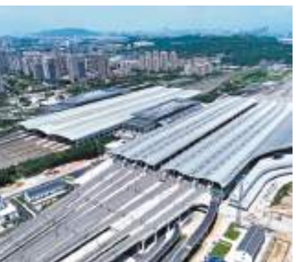
◆新建成的福廈高鐵路福州南站站房（8月29日攝，無人機照片）。新華社
