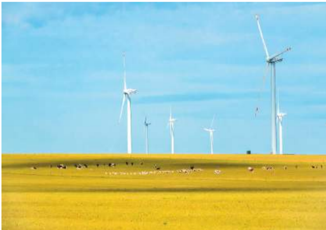
内蒙古自治区呼伦贝尔市近年立足光热资源丰富的优势，充分发挥“光伏+牧业”复合叠加效益，科学推进绿色新能源项目建设，助力边疆振兴。图为一排排风力发电机矗立在呼伦贝尔市陈巴尔虎旗美丽的草原上。
