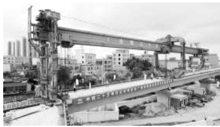
9月6日,广东省广州市,广州白云站枢纽京广高铁联络线最后一榀箱梁完成架设。李佳珊 摄
