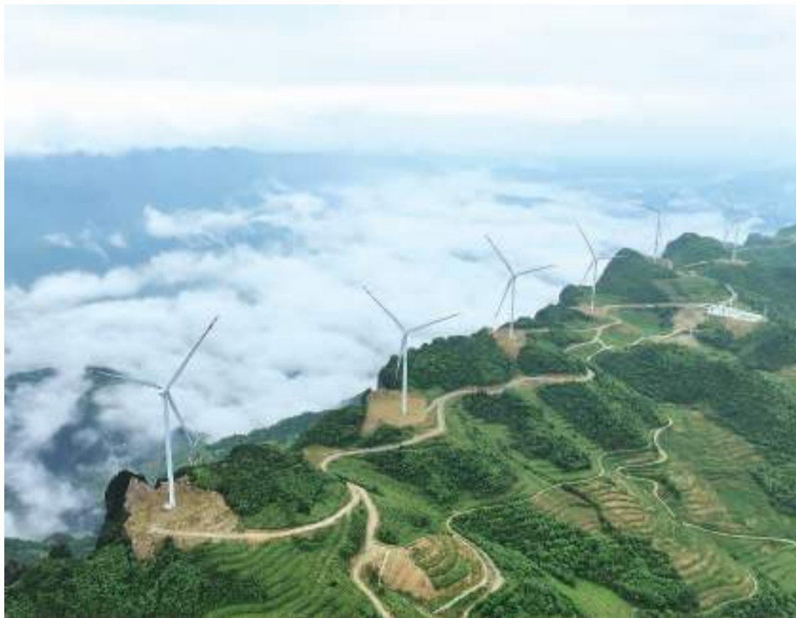
8月10日拍摄的重庆市黔江区五福岭风电场。
