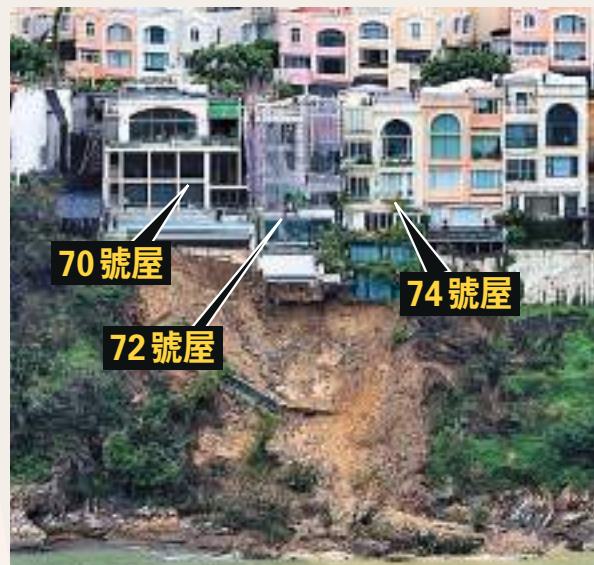
◆繼10日政府部門證實紅山半島72號屋有僭建情況，11日再證實70號屋亦涉僭建。另外，署方人員因被拒進入74號屋視察，擬向法院申請手令入屋調查。資料圖片
