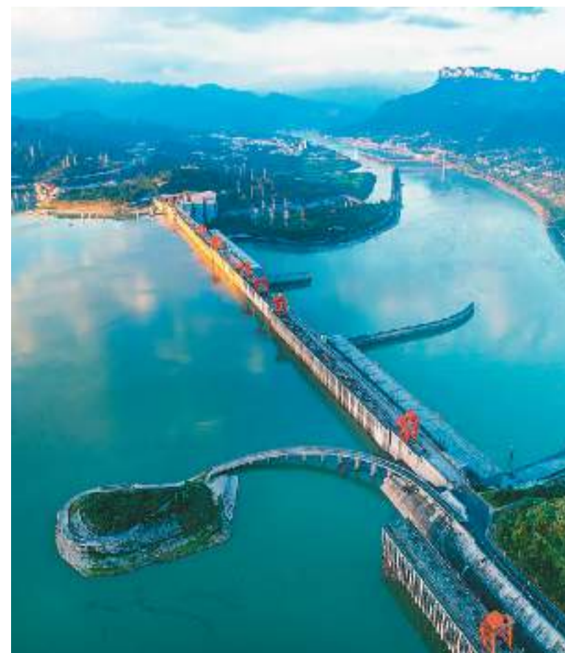
在湖北省宜昌市拍摄的三峡水利枢纽工程。
