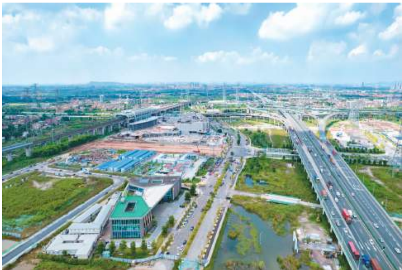
连日来,中国(广东)自由贸易试验区广州南沙新区片区庆盛枢纽区块一派热火朝天的建设景象,一幢幢建筑正拔地而起。该区块定位为“粤港枢纽·创新城区”,将打造为大湾区重要的科创枢纽新城、南沙科学城北组团产业中心。 吕华当摄(人民视觉)
