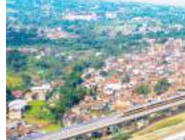
5月22日,正在联调联试中的雅万高铁。(中国铁路国际有限公司供图)
