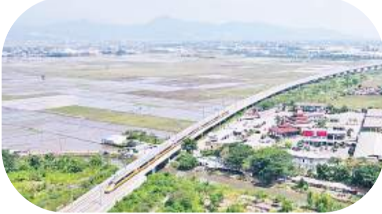
6月22日，在万隆，综合检测列车行驶在雅万高铁上(无人机照片)。
