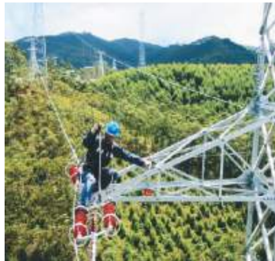
南方电网广西北海供电局积极推进配电网建设和智能化升级，增强电网分布式清洁能源接纳能力，为经济社会发展提供稳定、可靠电力。图为该局工作人员在进行清洁能源发电企业输电线路检修。
