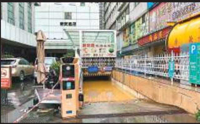
◆東門老街上圍地下停車場修繕「滅頂」，9日仍在排水。香港文匯報記者李望賢攝
