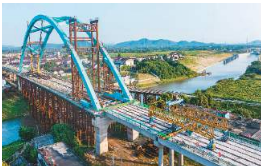
日前, 安徽省合肥巢湖市和庐江县之间的兆河上, 引江济淮工程引江济巢段沐林集大桥项目主体结构全线顺利贯通, 工程线路全长1.79公里, 对推动环巢湖经济发展将起到重要作用。图为桥梁附属设施施工现场。 左学长摄 (人民视觉)
