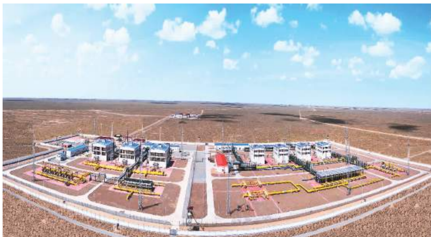
中乌天然气管道合资公司压气站。
