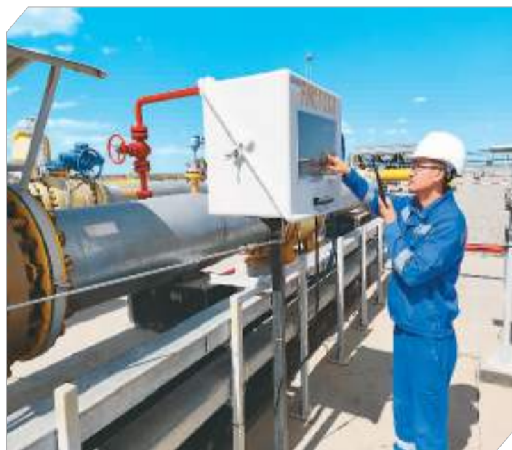
中哈天然气管道合资公司压气站员工在夏季高温下开展站场流量计区巡检。
