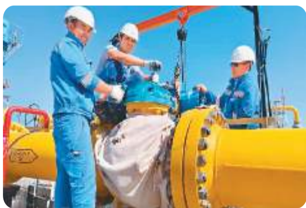
中哈天然气管道合资公司压气站员工开展球阀执行机构齿轮箱积水清理工作。
