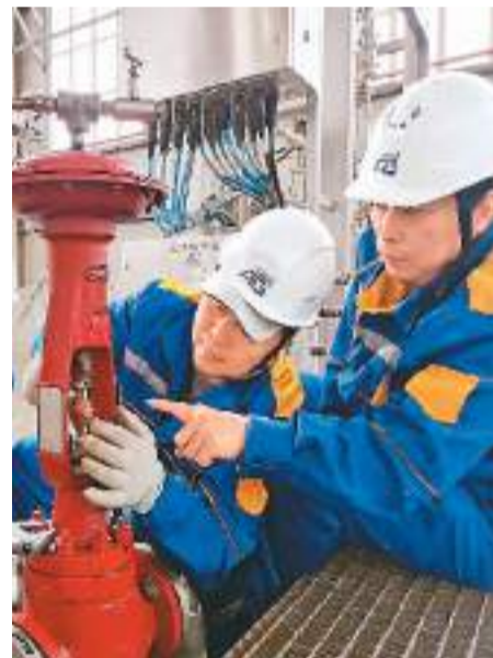
中乌天然气管道合资公司员工开展设备维护作业。
