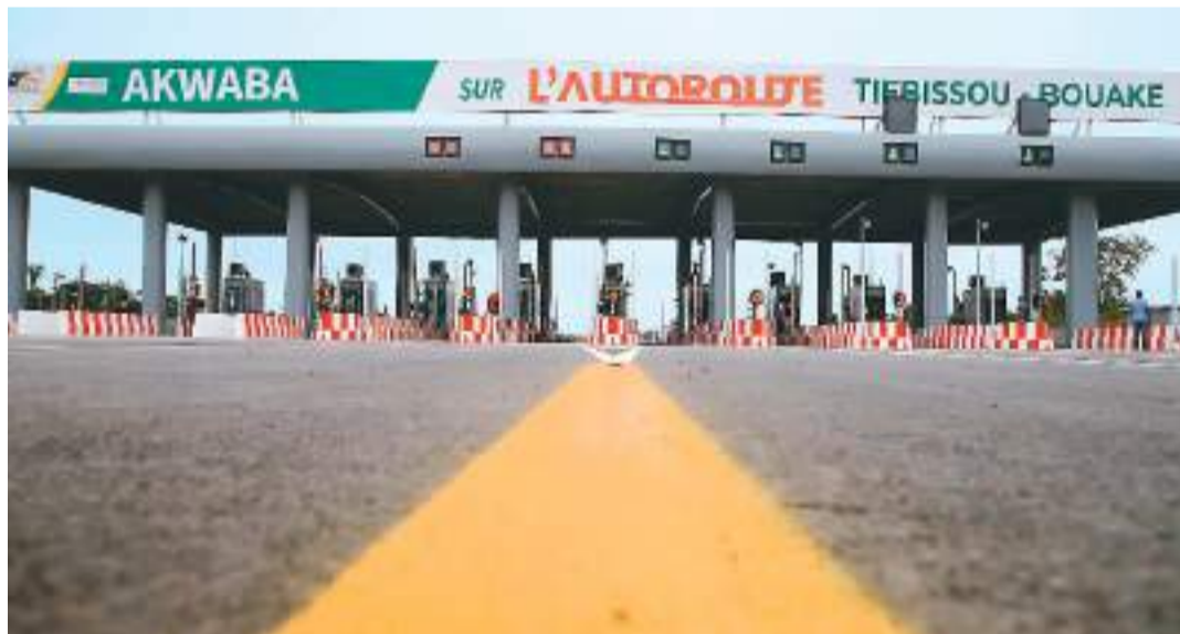
日前，由中国路桥工程有限责任公司（中国路桥）承建的科特迪瓦铁比苏—布瓦凯高速公路竣工通车。作为中科两国在“一带一路”倡议框架内的合作成果，铁布高速公路通车将为当地地区经济发展注入新活力。图为铁布高速公路项目现场。 伊万·宋摄（新华社发）
