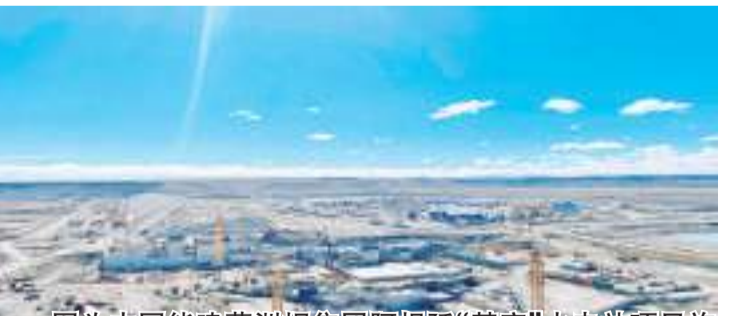
图为中国能建葛洲坝集团阿根廷“基塞”水电站项目施工现场。中新社记者 阿根廷驻华大使馆 供图
