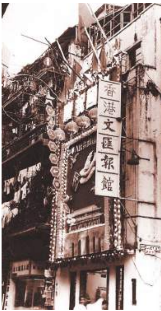
◆位於中環荷李活道30號的香港《文匯報》舊址（1948-1955）。建築物上有慶祝國慶燈飾。 資料圖片
