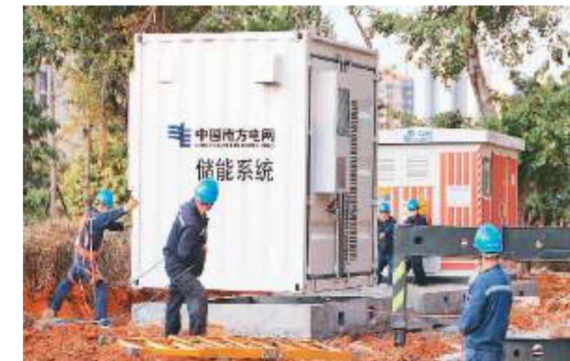
近年来，贵州省黔东南布依族苗族自治州大力推动“光伏+储能+电动车充电桩”新型城镇化示范项目建设。相关项目旨在推动新能源与电网统筹规划、融合发展，支持新能源快速有序发展，助力双碳目标实现。图为11月27日，南方电网贵州电网友人公司兴义供电局施工人员正在安装储能系统。 卢关文摄（人民视觉）
